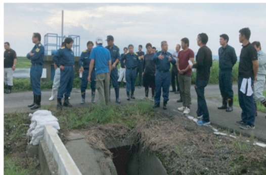
①久留米市北野町や大刀洗町の被災箇所。JA 青年部の方々と現地調査と意見交換。
